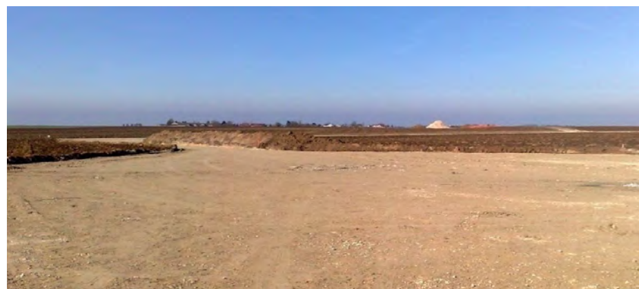
Figure 121 : Exemple d'aire de montage, grave compactée sur géotextile
