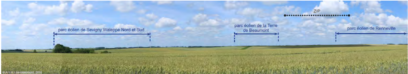
Figure 65 : D2 entre Sévigny-Waleppe et Hannogne-Saint-Rémy, avec vue sur les parcs éoliens de Renneville et de la Terre de Beaumont
