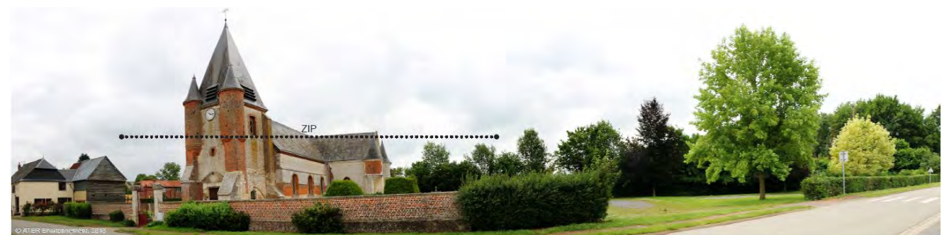
Figure 94 : Eglise fortifiée de Noircourt (n°125)
