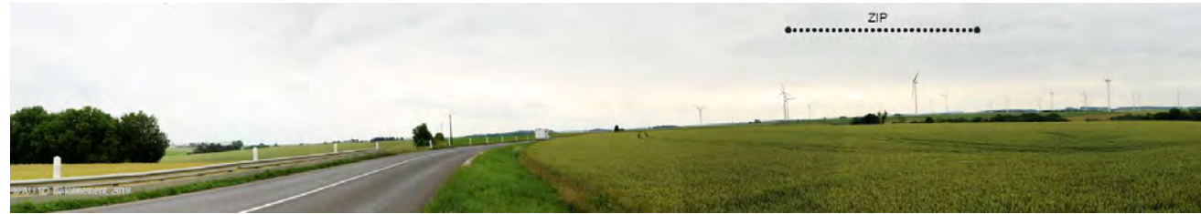
Figure 67 : La D966 à hauteur de la Ville-aux-Bois-lès-Dizy, avec vue sur l'ensemble éolien de Lislet
