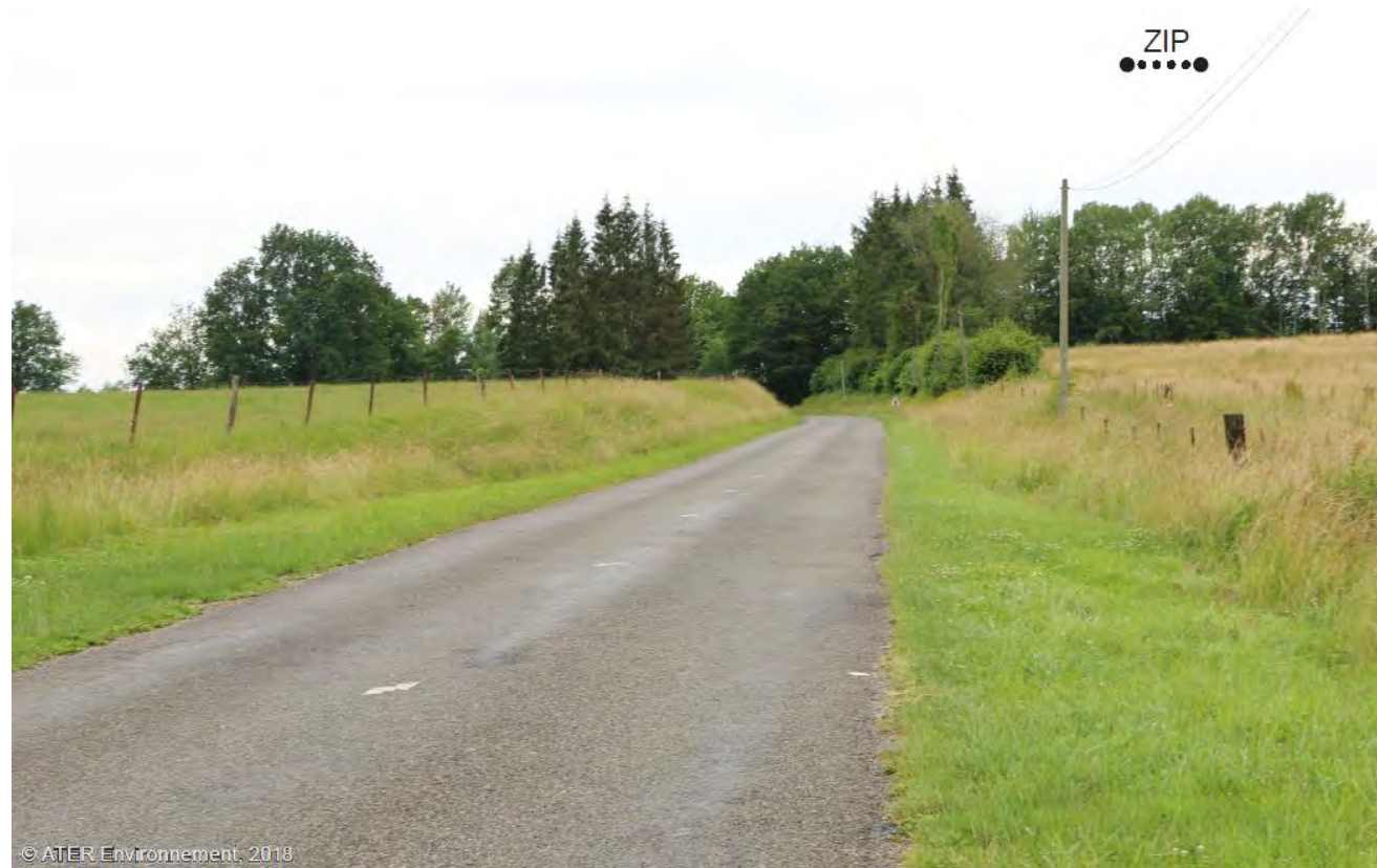
Figure 50 : La D2 en sortie Ouest du bourg de Draize
